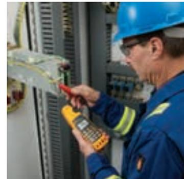
Messung von Prozesssignalen und anderen 4-20-mA-Stromschleifensignalen in der Automatisierungstechnik ohne Unterbrechen der Stromschleife
